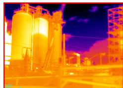
Kontrolle von Tankanlagen
