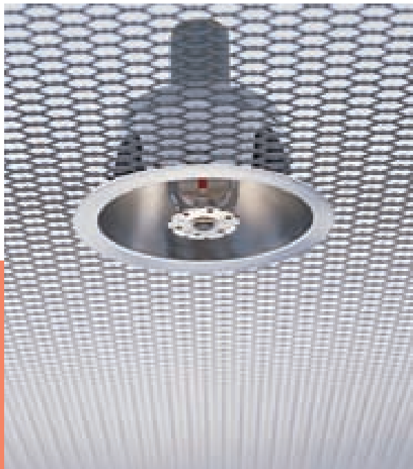
Zurückgesetzter Undercover-Sprinkler
