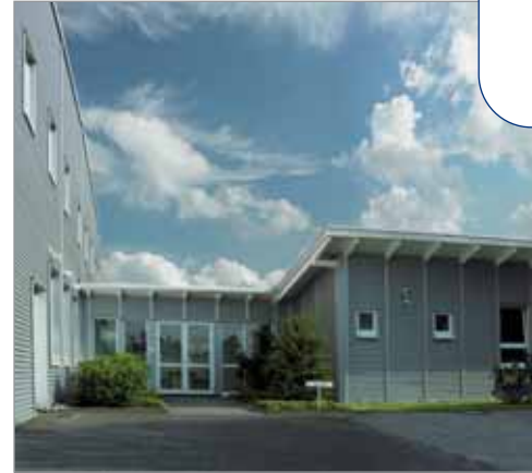
■ KABELSCHLEPP Hünsborn Service-Center
