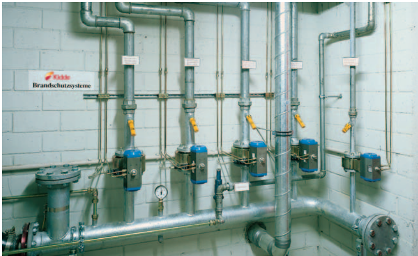
Bereichsventilverteiler für CO 2 -Niederdruckanlagen
