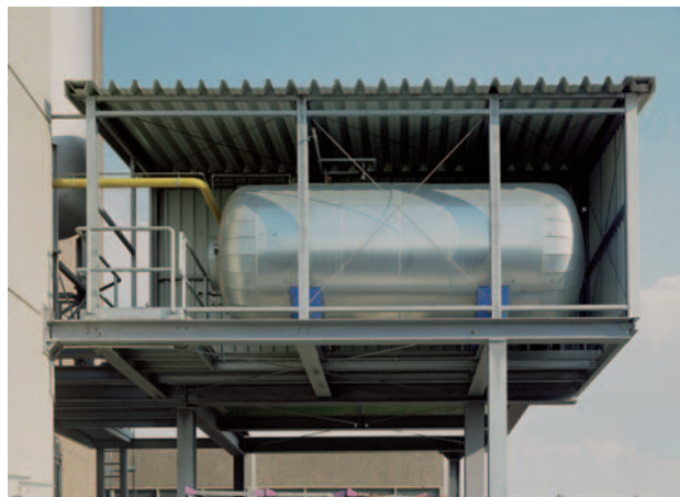
CO 2 -Niederdrucktank
