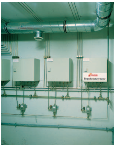
Anordnung von pneumatischen Zeitverzögerungen für 4 Löschbereiche
