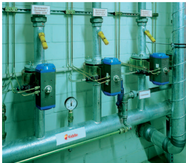
CO 2 -Niederdruck Bereichsventile
