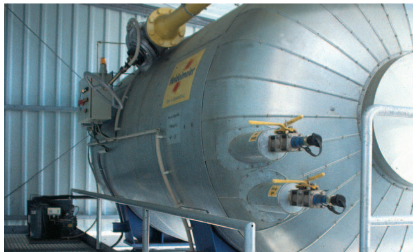
CO 2 -Vorratsbehälter mit elektronischer Wägezelle zur Schwundüberwachung
