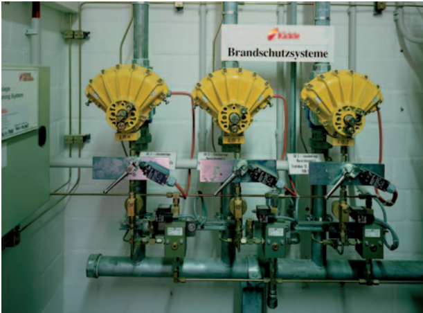
Bereichsventile für Hochdrucklöschanlagen
