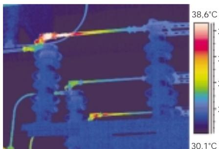
Oxidation eines Hochspannungsschalters
