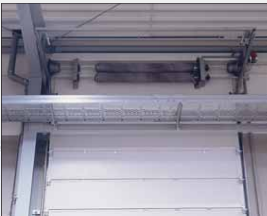
T30 Sectionaltor mit höhergeführtem Laufschienebeschlag.
