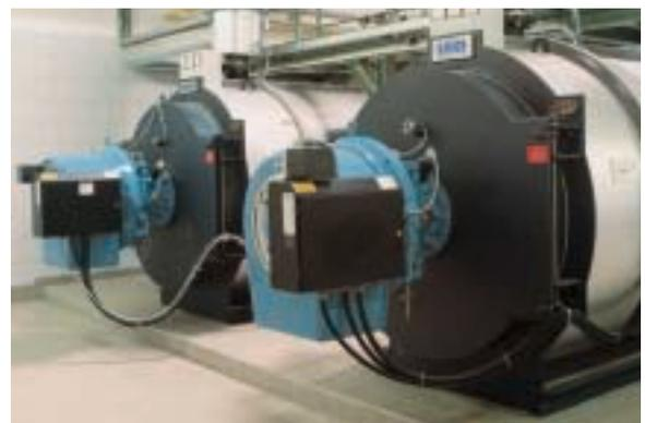
UNIMAT Heizkessel mit integriertem Abgaswärmetauscher zur Gebäudeheizung eines Industriebetriebes:
