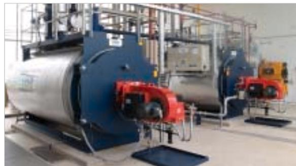
Zwei UNIMAT Heißwasserkessel vom Typ UT-M in einem Verpackungswerk zur Wärmeversorgung der Hallen
