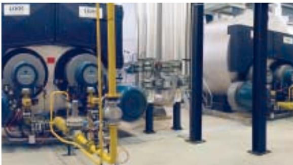
Zwei UNIMAT Heißwasserkessel vom Typ UT-HZ in einem Flughafen für die Heißwasser- und Wärmeversorgung
