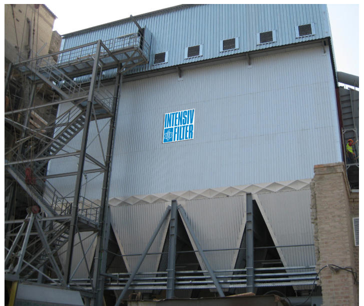
Doncement, Ukraine (HeidelbergCement) Umbau Elektrofilter ProJet mega® in offline Abreinigung Entstaubung Drehrohren
