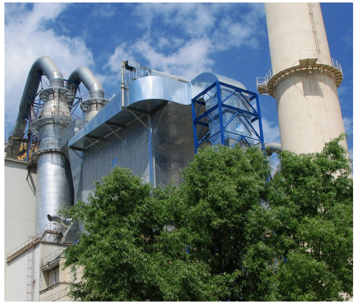
Deuna Zement GmbH, Deutschland (HeidelbergCement) Umbau Elektrofilter CombiJet Doppelfilter in semi-offline Abreinigung Entstaubung Drehrohren/Rohmehlmühle
