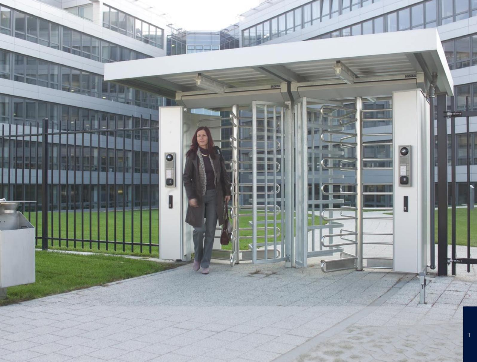
Die robusten Drehkreuze der Kentaur Produktfamilie eignen sich besonders für die zuverlässige Absicherung von Außenanlagen. In Verbindung mit Ausweislesern oder biometrischen Systemen übernehmen sie die Zugangs-
