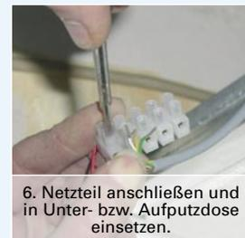
6. Netzteil anschließen und in Unter- bzw. Aufputzdose einsetzen.
