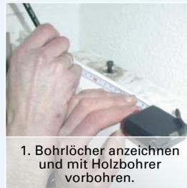
1. Bohrlöcher anzeichnen und mit Holzbohrer vorbohren.
