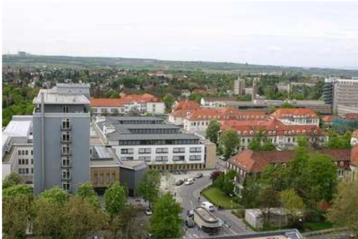
Bild 1: Das Netzwerk des Klinikums der Johannes Gutenberg-Universität Mainz verbindet auf 24 ha mit 177.000 qm Nutzfläche etwa 60 Bereiche, wie Kliniken, Verwaltung, diverse Schulen, etc.
